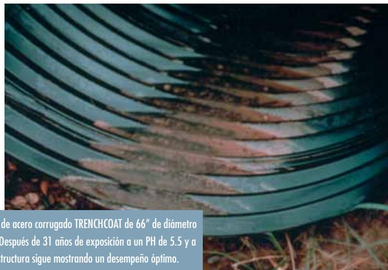
Instalada en 1975, esta tubería de acero corrugado TRENCHCOAT de 66" de diámetro está en excelentes condiciones. Después de 31 años de exposición a un PH de 5.5 y a una abrasión moderada, esta estructura sigue mostrando un desempeño óptimo.
