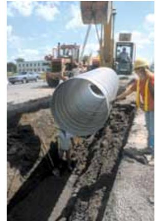
Se pueden ordenar, además, tubos de mayor longitud para proyectos especiales. El diámetro externo reducido del tubo ULTRA FLO permite reducir el ancho y la profundidad de las zanjas, lo que genera un ahorro importante en tiempo y costo, tanto en las excavaciones como en el relleno.
