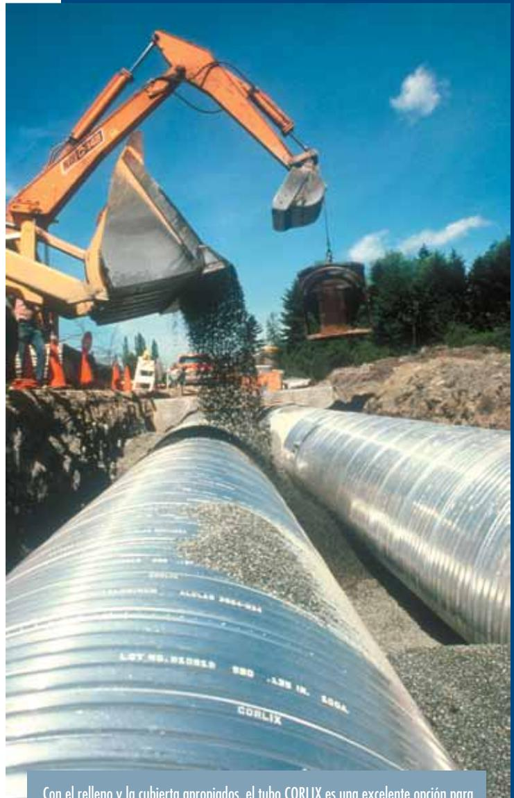
Con el relleno y la cubierta apropiados, el tubo CORLIX es una excelente opción para tuberías de drenaje.
